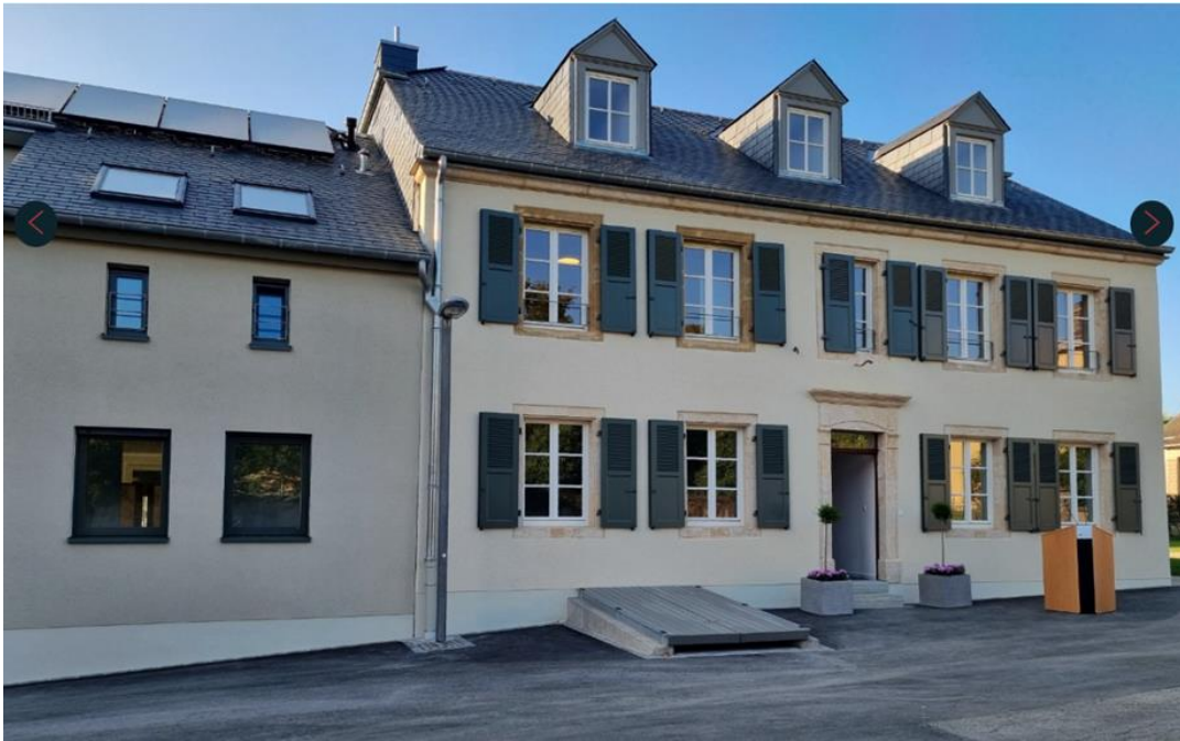
Peppange, Rénovation « Aal Paschtoueschhaus » – Administration communale de Roeser
